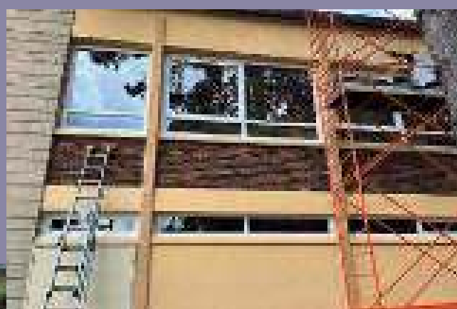
Réfection des peintures de façade - École Victor Hugo
