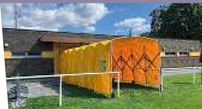
Installation d'un tunnel amovible - Stade Laumondé
