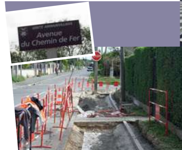
Avenue du Chemin de Fer - Travaux de réfection des trottoirs
